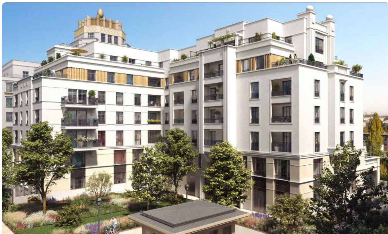
Opération Le Cap à Clamart
